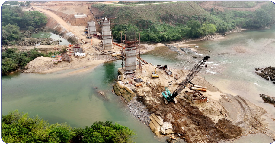
Hình 4.2. Thi công cầu qua sông đoạn xã Tân Quang (Bắc Quang) thuộc tuyến đường cao tốc Tuyên Quang – Hà Giang năm 2024
