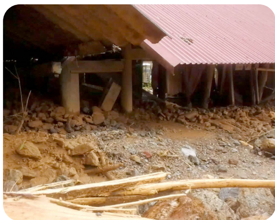
Hình 8.6. Sạt lở đất, cuốn trôi tài sản và nhà ở của người dân tại thôn Đồng Tâm, xã Yên Thành, huyện Quang Bình
